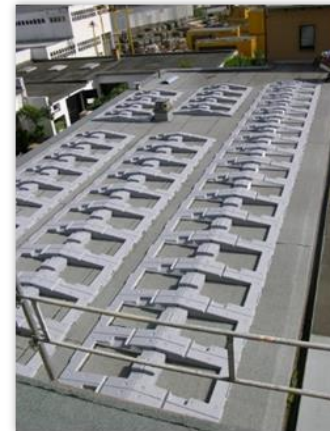
Träger mit UV-Schutz versehen
