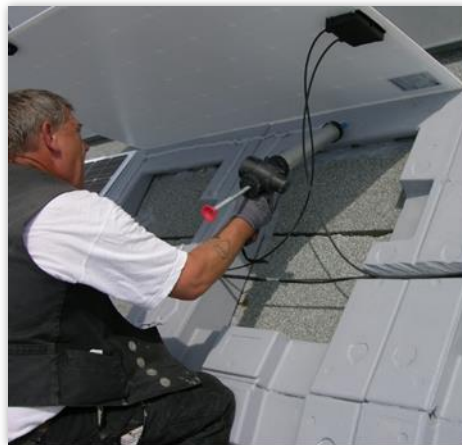
Kleber für die Module auf dem Träger auftragen und Module verkabeln
