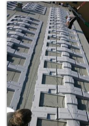
Verlegen der Stringverkabelung
