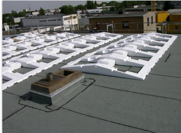
Träger auf die Dachhaut kleben
