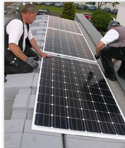
Module auflegen und ausrichten
